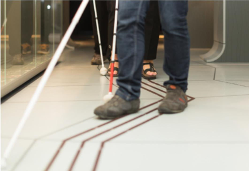
Ein taktiles Bodenleitsystem kann mit dem Langstock und den Füßen ertastet werden, Foto: Mark Frost
